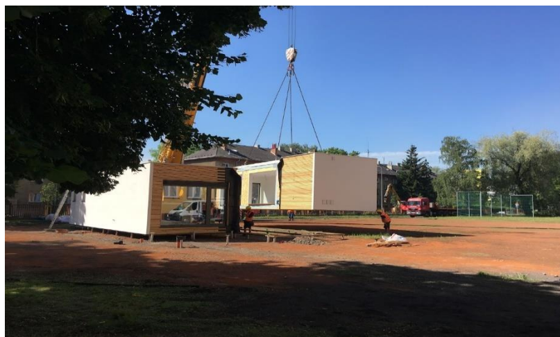
Obr. 1 – montáž modulů – červen 2022:
